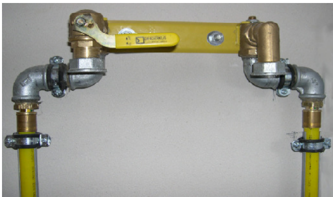
Bild : Gas-Zähleranschlussplatte – Anschluss mit nicht metallenen Leitungen
