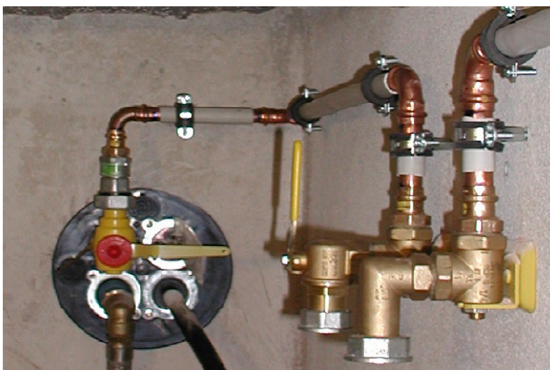
Bild : Anschluss einer Gaszähler-Anschlussplatte
